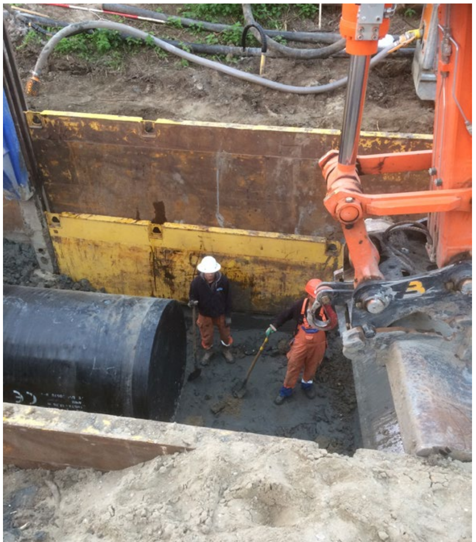
Omleggen van een drinkwatertransportbuis met een diameter van 180 cm.
