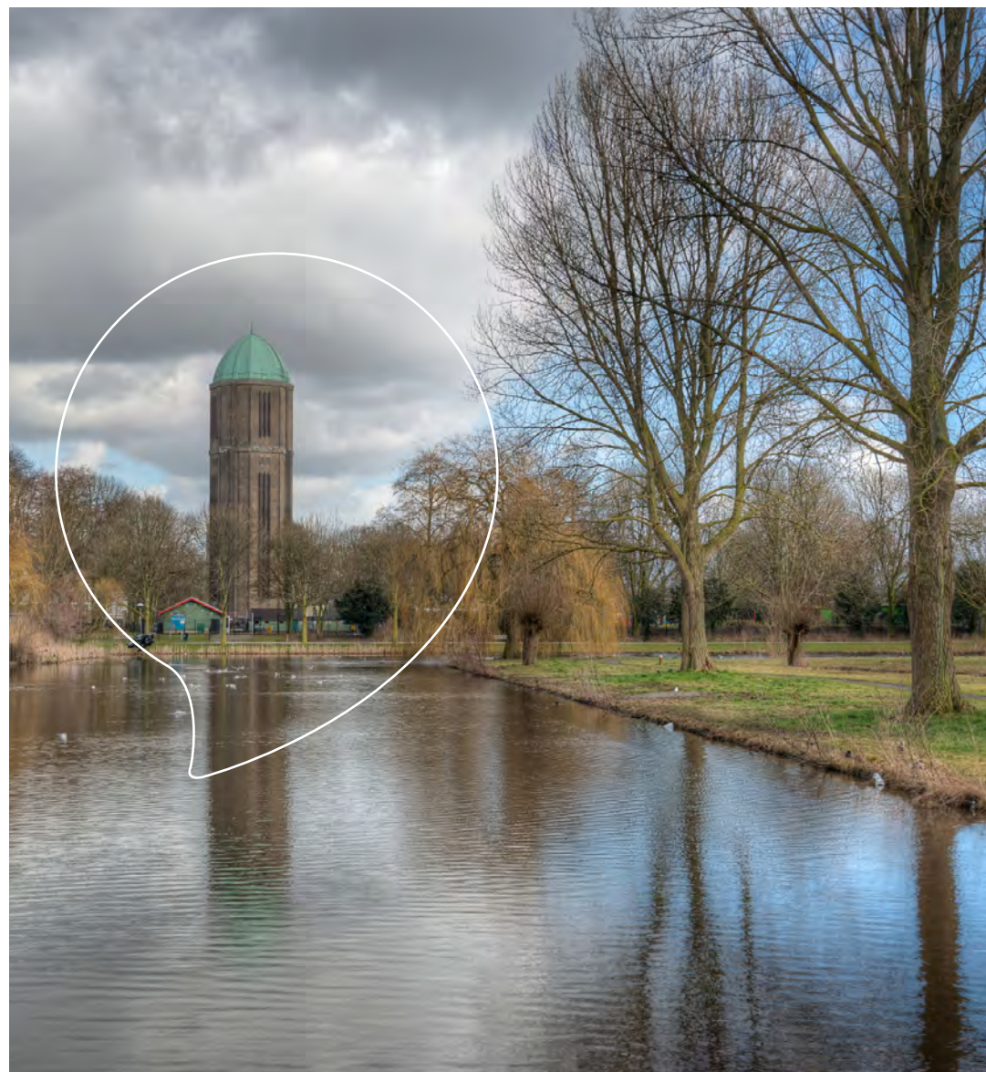
Foto: Watertoren Vitens in Overvecht. Een watertoren zorgt ervoor dat er continu druk blijft staan op het waterleidingnet - ook bij een eventuele stroomuitval.
