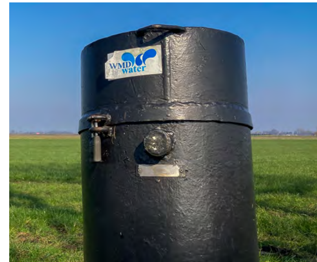
Foto: Monitoringsput voor grondwater, van WMD
